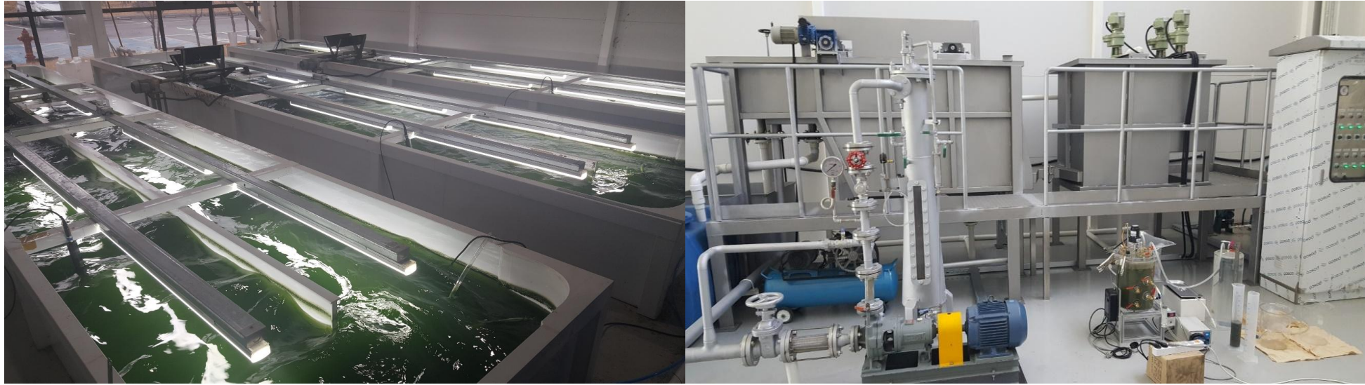
국가물산업클러스터(대구 달성군 소재) 수요자설계구역 내 미세조류 하수처리, 수확 및 메탄가스 생산 연구시설
